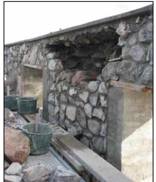
Den östra murens insida efter restaurering. Partiet mellan fönstren i bild är nästan helt ommurat från samma nivå som högra fönstermursens botten. Även över fönstren är murverket ommurat från insidan och nya ekplank inlagda. Tegelmattningarna har lagats och slammats. I öppningen efter det försvunna bjälklaget har stabiliserande ekbjälkar monterats.
